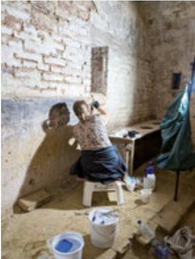
Restaurierungsarbeiten im Bereich der ehemaligen Latrine. Quelle: Maria Prochniak.
