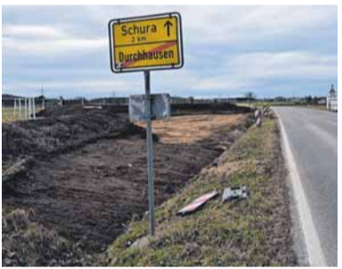
An den Vorarbeiten kann man schon erkennen, dass hier ein Kreisverkehr entstehen wird. FOTO: ANDREA UTZ
